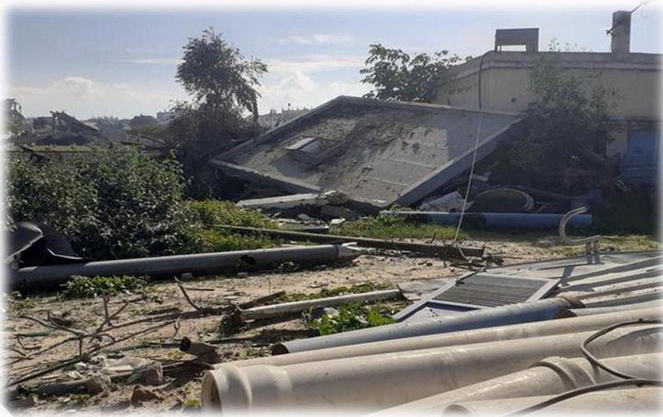
صورة 4 الدمار الذي لحق بشبكات ومحطات ضخ المياه
